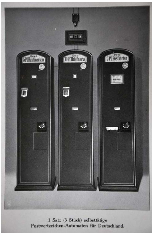
5-Pf- und 10-Pf.-Postwertzeichengeber und Postkartengeber der Firma Dapag 6
